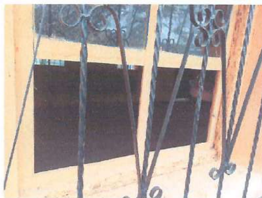
Foto 2: Mejoramiento e instalación de ventanas
