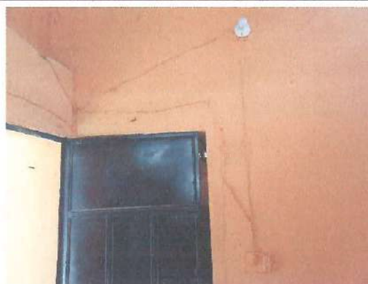
Foto 3: Reparación del sistema eléctrico
