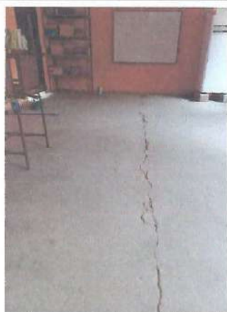
Foto1: Mejoramiento e instalación de piso de granito
