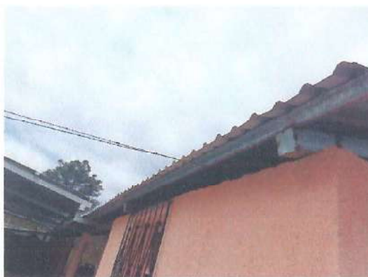
Foto 4: Instalación de canales y bajadas de agua pluvial
